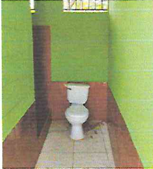
Foto 7: instalación de inodoro y piso cerámico en baño.
