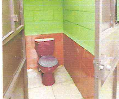
Foto 8: Instalación de piso cerámico en baños.
