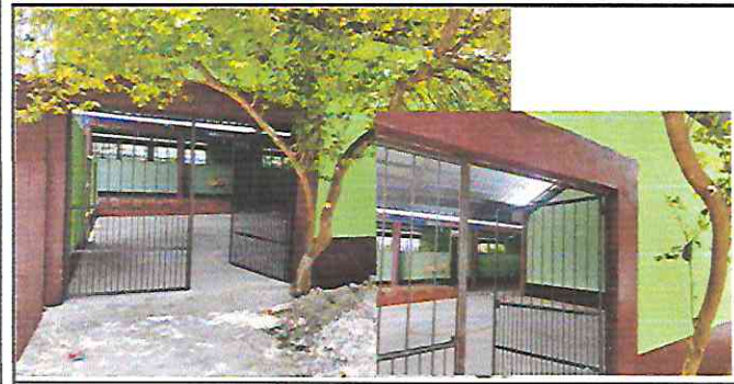
Foto 5: Instalacion de porton de metal y pintura.
