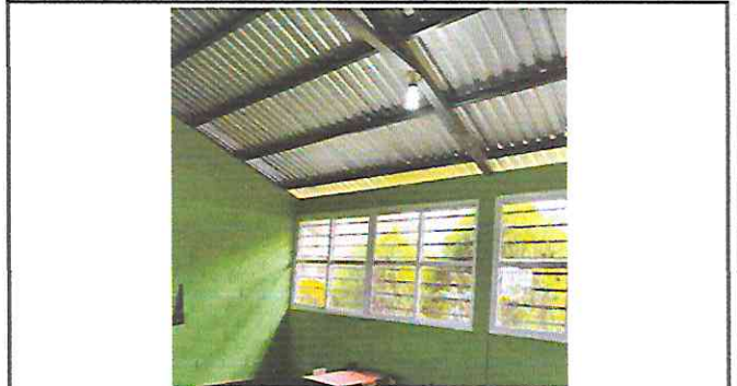
Foto 2: Cambio de lamina troquelada aluzinc cal. 26.
