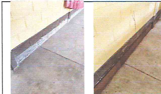
Foto 3: Instalacion de zocalo ceramico en aulas.
