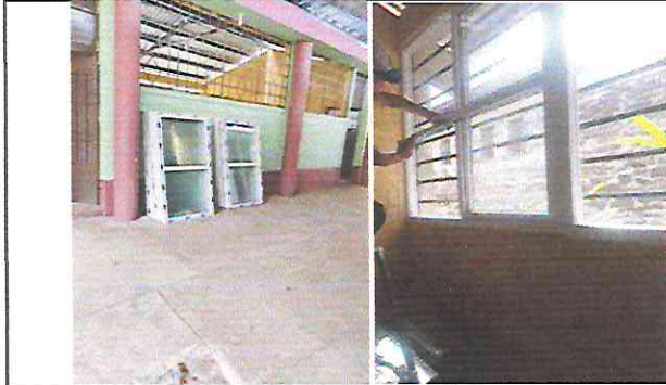
Foto 1: Instalacion de ventanas de PVC.
