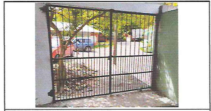
Foto 6: Instalacion de porton de metal.
