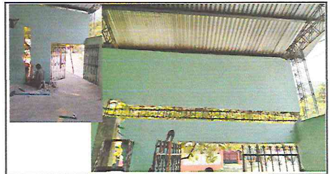
Foto 4: Demolicion de muro para vano de porton y rezanado.
