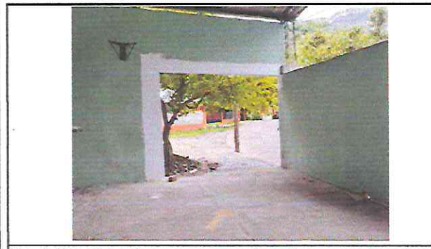
Foto 5: Demolicion de muro para vano de porton y rezanado.
