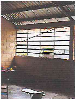
Foto 3: Cambio de ventaneria en mal estado por ventanas de PVC e instalacion de balcones.
