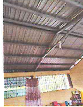
Foto 2: Cambio de lamina con multiples filtraciones.
