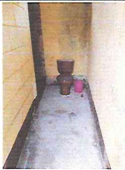
Foto 5: Cambio de artefacto sanitario, asi como colocacion de piso ceramico.
