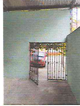
Foto 4: Cambio de porton de ingreso, el existente en mal estado y las dimensiones son reducidas.
