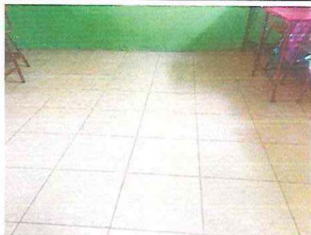
Foto 3.2. Sustitución o instalación de piso de torta de concreto
