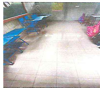
Foto 1.2. Sustitución o instalación de piso cerámico
