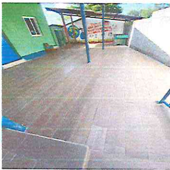
Foto 1.2. Sustitución o instalación de piso cerámico
