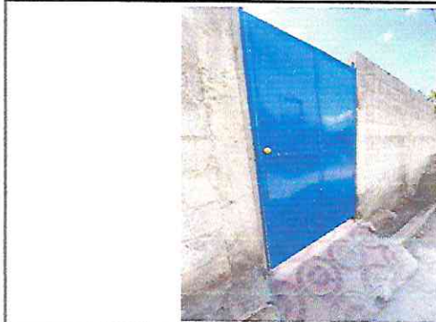
Foto 3.1. Sustitución o instalacion de portón de metal
