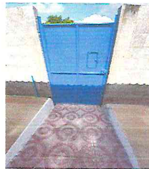
Foto 3.1. Sustitucion o instalacion de portón de metal
