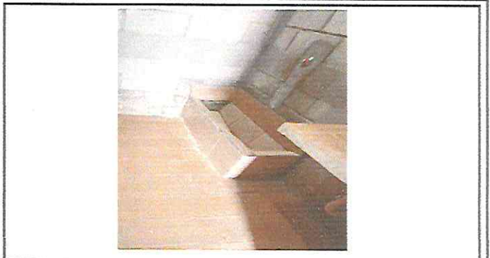
Foto 2.1. Reparación de instalaciones de mingitorio
