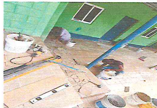
Foto 1.2. Sustitución o instalación de piso cerámico
