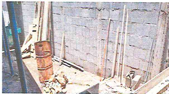
Foto 1.2. Sustitución o instalación de piso cerámico
