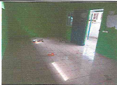
Foto 1.2. Sustitución o instalación de piso cerámico
