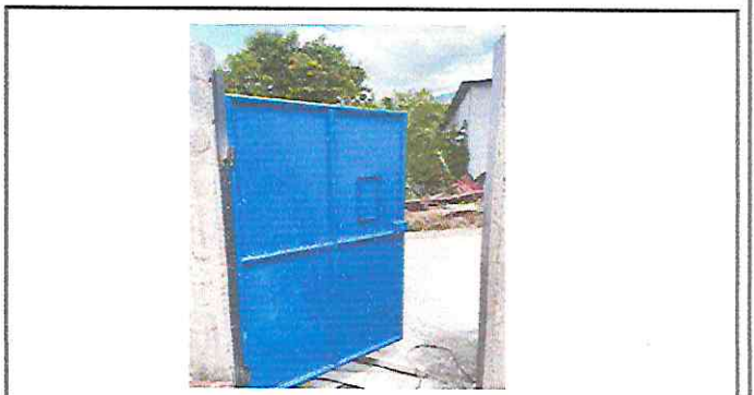
Foto 3.1. Sustitucion o instalacion de portón de metal
