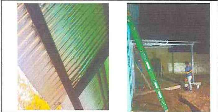
1.1. sustitución de lámina por lámina. 2.2. sustitución de estructura de madera por metal.
