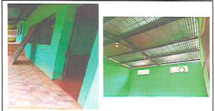
2.3. sustitución de estructura de soporte de metal por metal. 4.1. mantenimiento de estructura. 4.2. Sustitución de Chapas.
