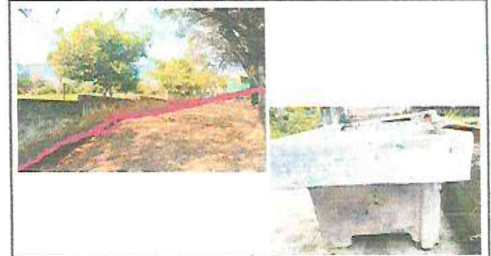
14.9 y 19.21 Sustitución de tubería línea principal. 14.12 y 19.22 Sustitución de llave de chorro. 20.10 Sustitución de pila de cemento de dos lavaderos.
