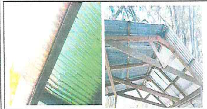
1.1 Sustitución de lámina por lámina. 2.2 sustitución de estructura de madera por metal.
