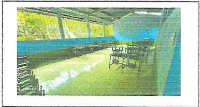
Foto 2: sustitucion de piso de torta de cemento
