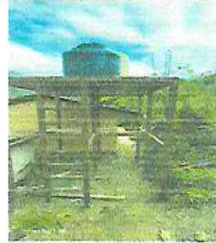
Foto 8: instalacion de estructura portante de metal
