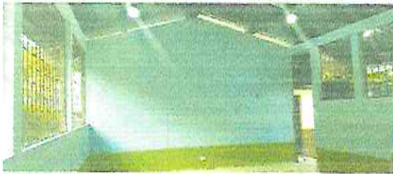
Foto 9: repello en muro
