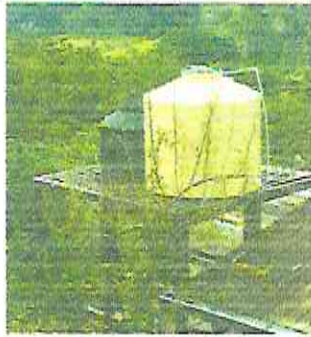
Foto 7: reparación y mantenimiento de cisterna
