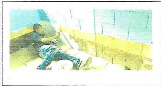
Foto 9: repello en muros
