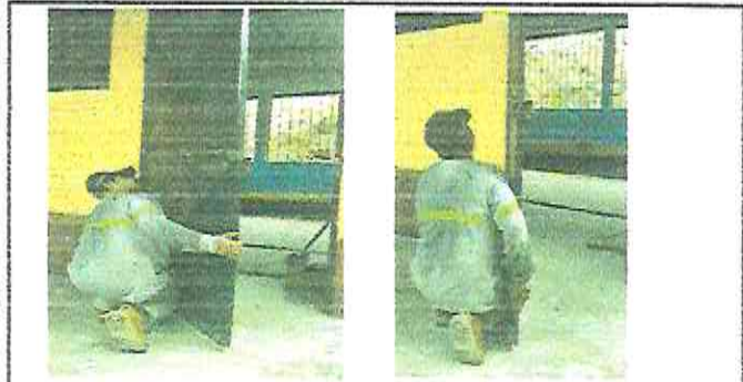
Foto 1: Mantenimiento de estructura de puertas y cambio de chapas
