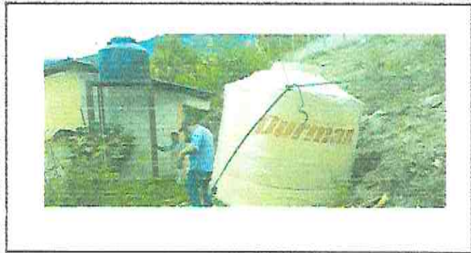
Foto7: reparacion y mantenimiento de sistema
