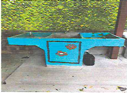
Sustitución, suministro e instalación de pila de concreto.
