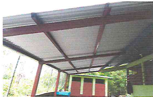
Ampliación de techo, fabricación de alero con estructura metálica.
