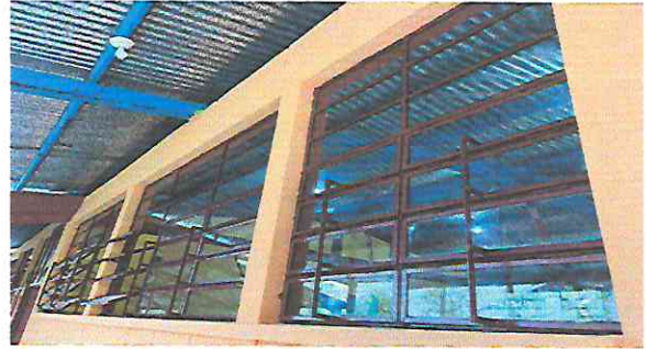
Reparación de ventanas en general.
