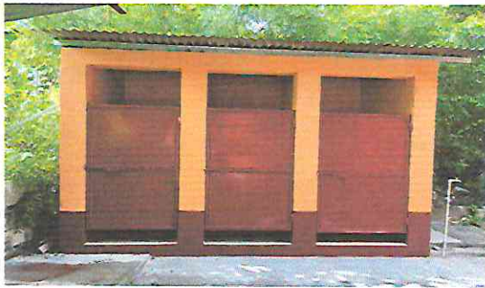
Mantenimiento de estructura y sustitución de chapa a puertas de metal con chapas de primera calidad, 3 puertas.
