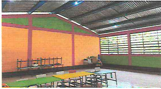
Pintura en muros exteriores e interiores.
