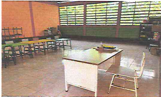
Suministro, reparación y colocación de piso cerámico Mate.
