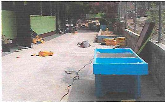
Sustitución, suministro e instalación de pila de concreto.
