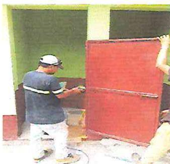
Mantenimiento de estructura y sustitución de chapa a puertas de metal con chapas de primera calidad, 3 puertas.
