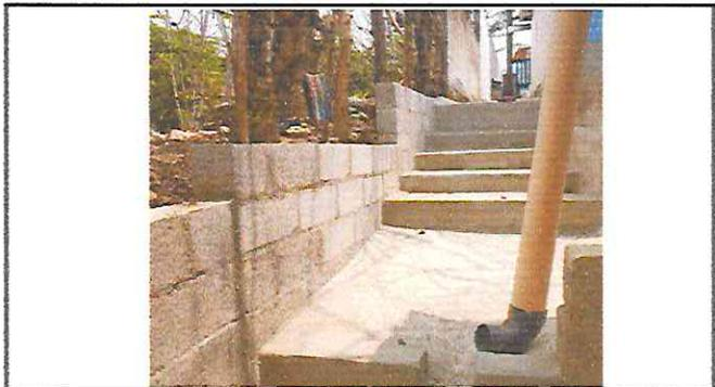
FOTO 2. INSTALACION DE PLANCHAS DE CONCRETO EN BAJADA DE AGUA PLUVIAL
