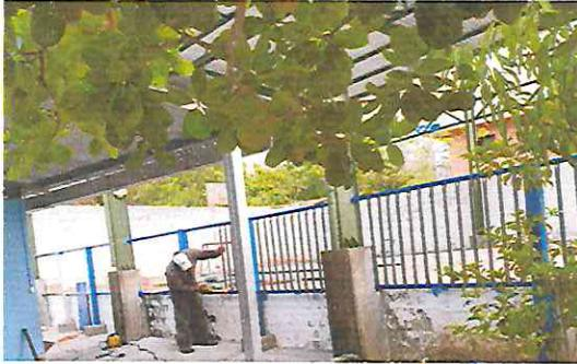
FOTO 3.2 INSTALACIÓN DE BARRANDA DE TUBO HG AREA DE CANCHA
