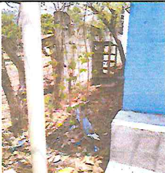
Foto 1: BAJADA DE AGUA
