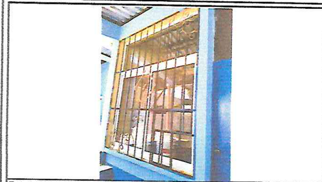
Foto1: BALCONES AREA DE COCINA
