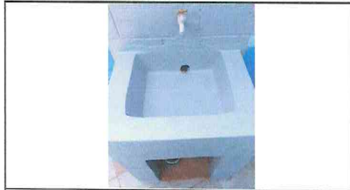
Foto 1: Rehabilitación de Lavamanos. (REMOZAMIENTO TERMINADO)
