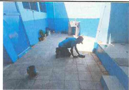
Foto 18: Reparación y Rehabilitación de Piso de Torta para Instalar Piso Ceramico en Area de Escenario.
