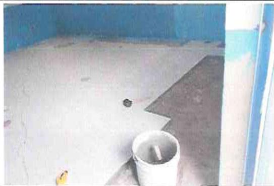
Foto 8: Reparación y Ampliación de Piso Granito (Monostrato) en Aula de Parvulos.
