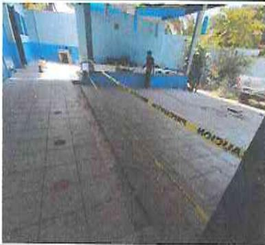
Foto 17: Reparación y Rehabilitación de Piso de Torta para Instalar Piso Ceramico en Area de Escenario.
