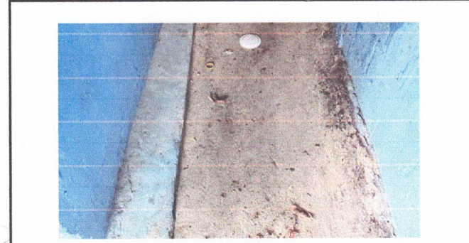
FOTOGRAFIA: INSTALACION DE PISO CERAMICO
