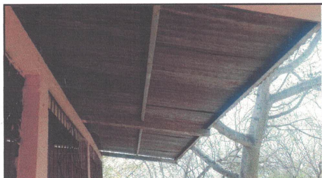
Fotografía 6: Vista del techo en el área del corredor.
