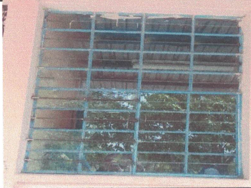
Fotografía 8: Vista general de ventanas.
