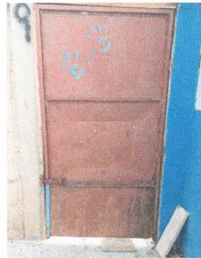
Foto 8: Mantenimiento a estructura de puerta (lijado, cambio de tubo, cepillado, sujeciones, aplicación de pintura) y cambio de chapa puerta parte de atrás de la escuela.
