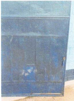
Foto 9: Mantenimiento a estructura de puerta (lijado, cambio de tubo, cepillado, sujeciones, aplicación de pintura) y cambio de chapa parte de enfrente de la escuela.
