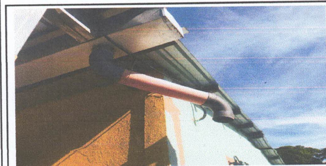
FOTOGRAFIA: REPARACION DE CANAL Y SISTEMA DE BAJADA PLUVIAL EN ESCENARIO
