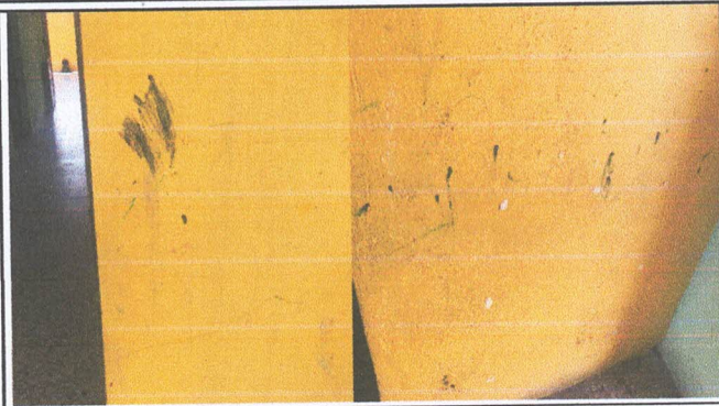
FOTOGRAFIA: PINTURA EN MUROS INTERIOR Y EXTERIOR
