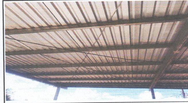
FOTOGRAFIA: SUMINISTRO E INTALACION DE SISTEMA ELECTRICO EN ESCENARIO
