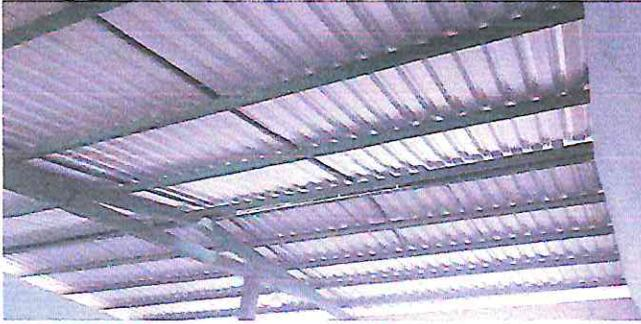
**SUSTITUCIÓN DE LÁMINAS EN AULAS POR ENCONTRARSE OXIDADAS Y PICADAS, POR LAMINAS TROQUELADAS DE ALUZINC CALIBRE 26.**
