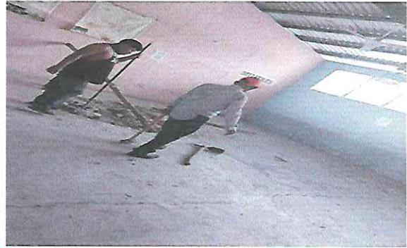
DEMOLICIÓN DE TORTA (PISO) EN AULAS POR ENCONTRARSE CON GRIETAS Y LEVANTANDO DE LA PASTA DE DE CEMENTO
