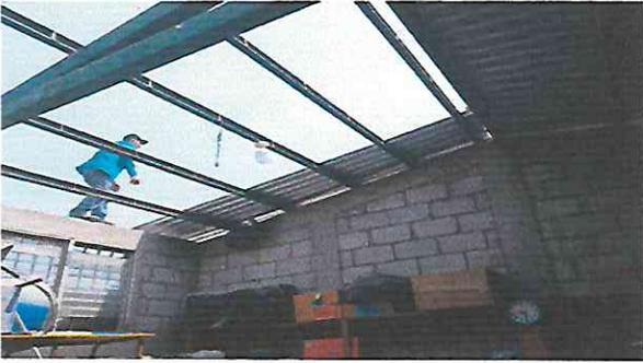
SUSTITUCIÓN DE LÁMINAS EN AULAS POR ENCONTRARSE OXIDADAS Y PICADAS, POR LAMINAS TROQUELADAS DE ALUZINC CALIBRE 26.
