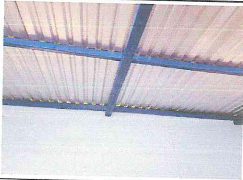
FOTO 1: Sustitución de instalación de lámina por lámina troquelada zinc calibre 26
