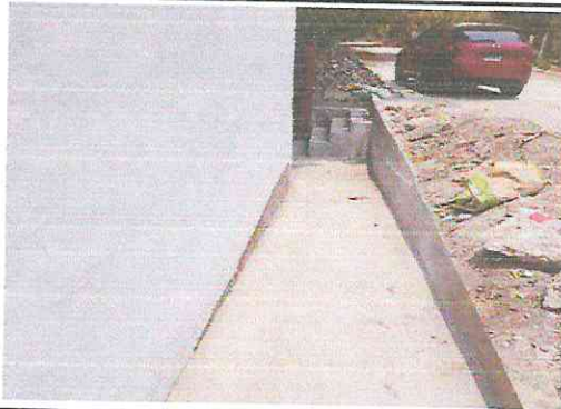
FOTO 3: Sustrucción o instalación de rampa de ingreso
