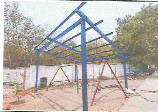
FOTO 6: Mantenimiento de Área de Juegos
