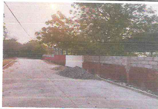
FOTO 4: Agregar altura al muro perimetral
