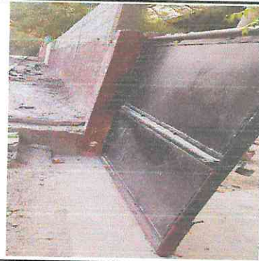
FOTO 2: Mantenimiento de portón de metal
