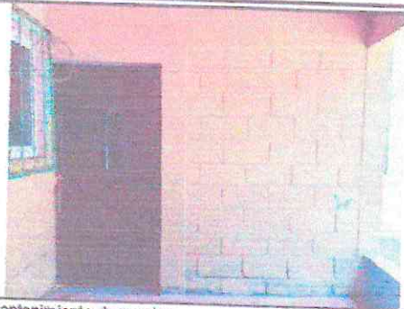
Foto 1: Mantenimiento de puertas.
