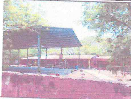
Foto 2: Agregar altura al muro perimetral.
