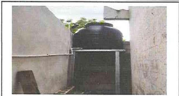
Foto 2.3 y 2.4: Instalación de base de estructura metálica para instalación de Tanque de agua
