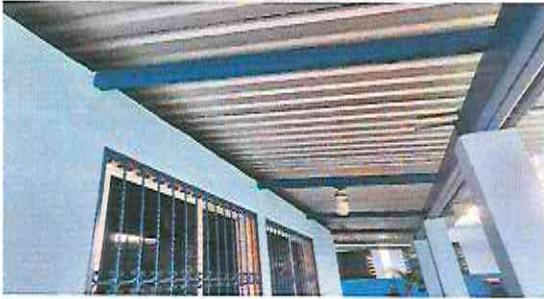
Foto 1.1: Sustitución de laminas
