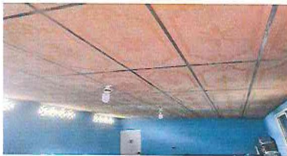
Foto 1.3: Sustitución de cielo falso
