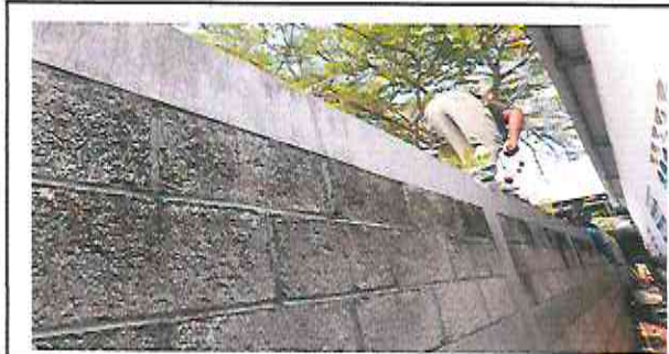
Foto 3.1: Reparación de muro perimetral de block
