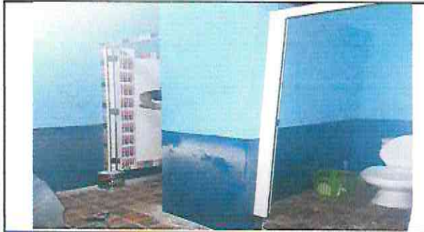
Foto 2.2: Sustitución de puertas
