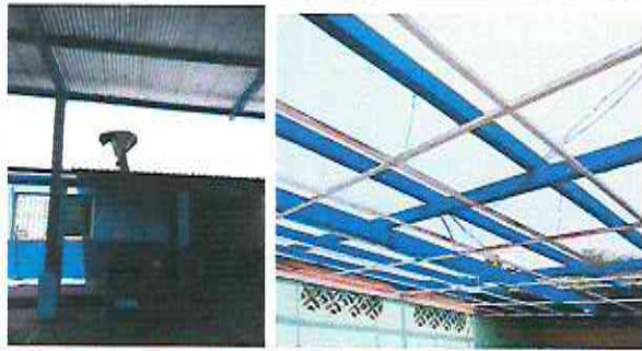
Foto 1.1: Sustitución de laminas
