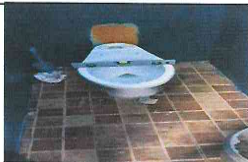
Foto 2.1: Sustitución de inodoros
