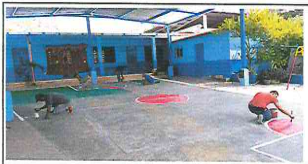
Foto 4.1: Sustitución de pintura en cancha de basquetbol
