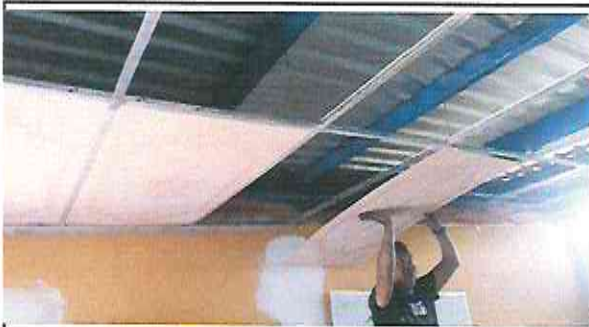
Foto 1.3: Sustitución de cielo falso
