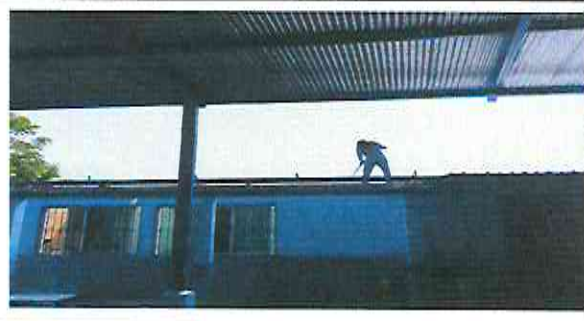
Foto 1.2: Mantenimiento a estructura de soporte de metal
