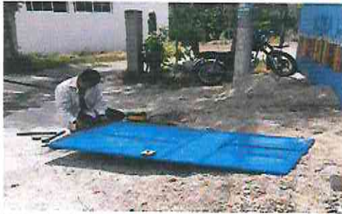
Foto 1.5: Sustitución de puerta de metal
