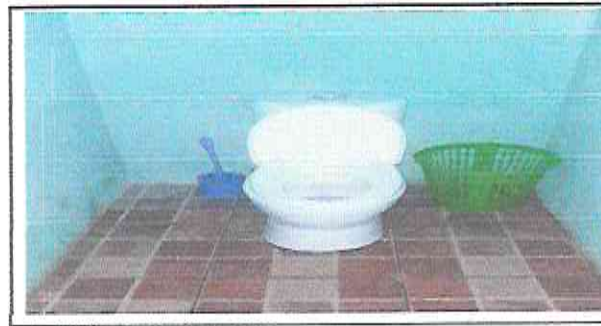
Foto 2.1: Sustitución de inodoros
