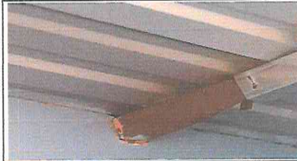
Foto 1.2: Mantenimiento a estructura de soporte de metal
