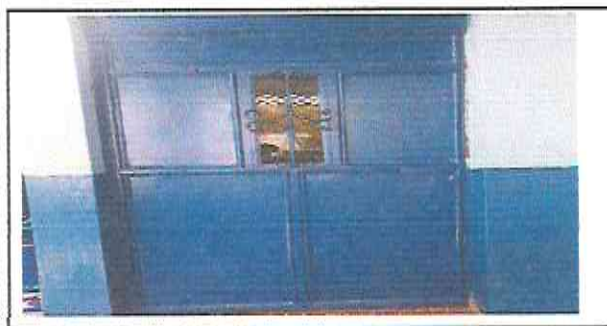
Foto 1.5: Sustitución de puerta de metal
