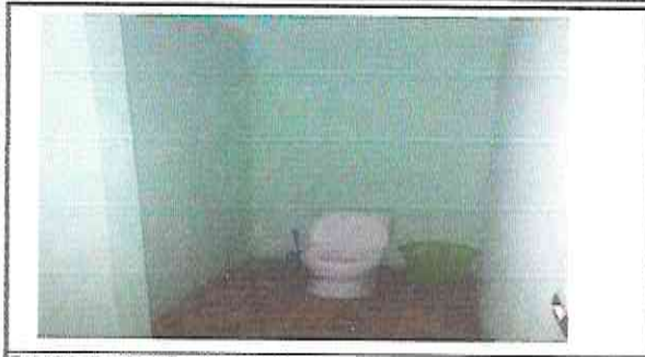
Foto 2.2: Sustrucción de puertas
