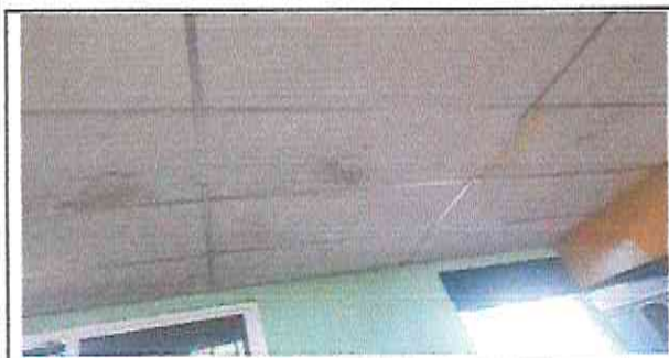
Foto 1.3: Sustitución de cielo falso
