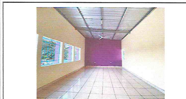
Foto 3. Repello, cernido y pintura en muro interno aula 1
