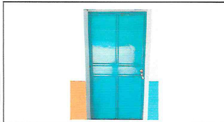
Foto 1. Mantenimiento de estructura de metal de puerta aula 1
