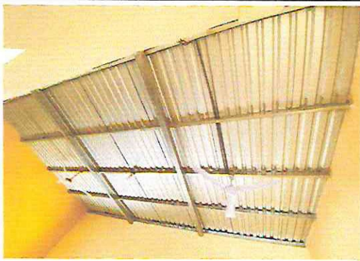
foto 9. Sustitución de lámina por lámina troquelada aluzinc calibre 26, levantado de muro con block para elevar el techo de lámina, sustitución de estructura de soporte de madera por metal aula 1
