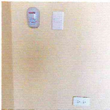
foto 11. Sustitución de tomacorrientes dobles
