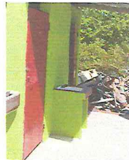
Foto 14. Sustitución de puertas de sanitario
