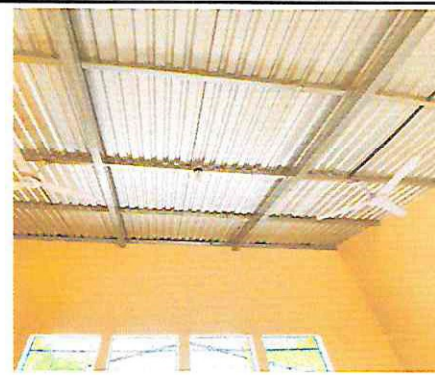
foto 10. Sustitución de lámina por lámina troquelada aluzinc calibre 26, levantado de muro con block para elevar el techo de lámina, sustitución de estructura de soporte de madera por metal aula 2
