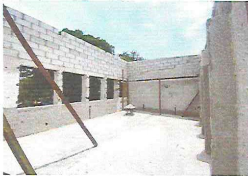
foto 9. Sustitución de lámina por lámina troquelada aluzinc calibre 26, levantado de muro con block para elevar el techo de lámina, sustitución de estructura de soporte de madera por metal aula 1
