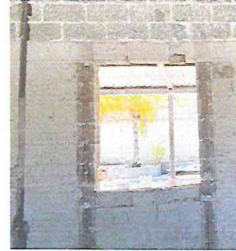
foto 8. Mantenimiento de estructura de metal de ventana aula 2
