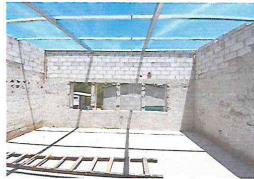
foto 10. Sustitución de lámina por lámina troquelada aluzinc calibre 26, levantado de muro con block para elevar el techo de lámina, sustitución de estructura de soporte de madera por metal aula 2
