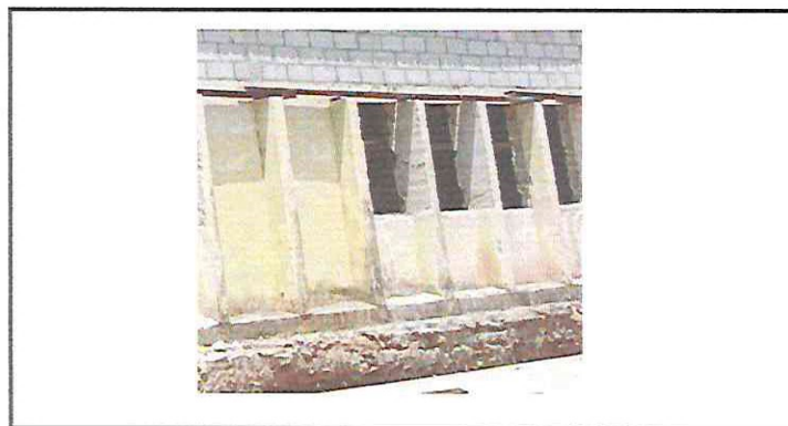
foto 6. Repello, cernido y pintura en muro externo aula 2
