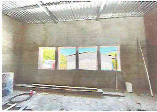
foto 7. Mantenimiento de estructura de metal de ventana aula 1
