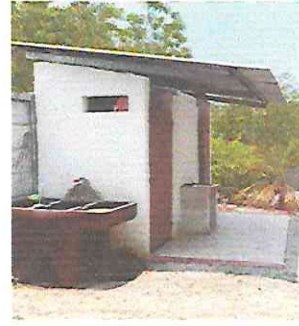
Foto 14. Sustitución de puertas de sanitario
