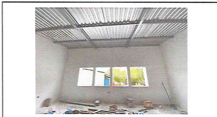
Foto 4. Repello, cernido y pintura en muro interno aula 2
