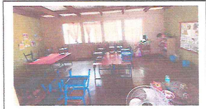
Foto 4. Repello, cernido y pintura en muro interno aula 2
