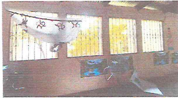
Foto 7. Mantenimiento de estructura de metal de ventana aula 1
