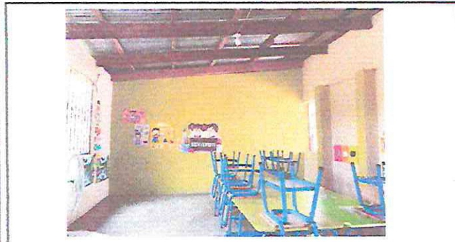
Foto 3. Repello, cernido y pintura en muro interno aula 1
