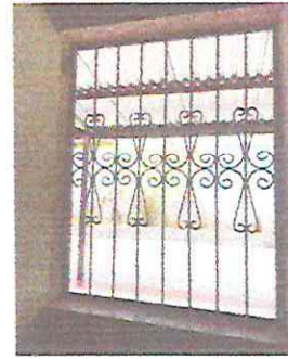
Foto 8. Mantenimiento de estructura de metal de ventana aula 2
