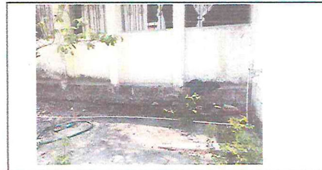
Foto 6. Repello, cernido y pintura en muro externo aula 2
