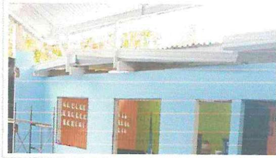
FOTOGRAFÍA No. 4 SUMINISTRO E INSTALACIÓN DE CANAL
