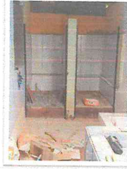
FOTOGRAFÍA No. 8 INSTALACIÓN DE SANITARIO
