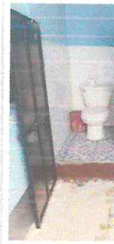
FOTOGRAFÍA No. 10 REPARACIÓN DE PUERTAS EN ÁREA DE SANITARIOS
