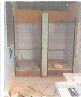
FOTOGRAFÍA No. 6 SUMINISTRO E INSTALACIÓN DE PISO CERÁMICO
