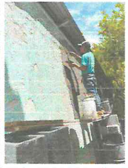
FOTOGRAFÍA No. 1 REPELLO Y SANITIZACIÓN EN MUROS
