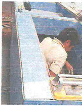
FOTOGRAFÍA No. 9 SUSTITUCIÓN DE PILA DE DOS LAVADEROS
