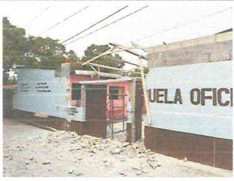
FOTOGRAFÍA No. 3 SUSTITUCIÓN DE LÁMINA
