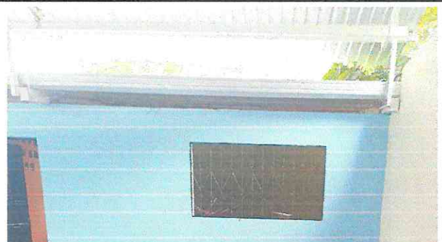
FOTOGRAFÍA No. 4 SUMINISTRO E INSTALACIÓN DE CANAL
