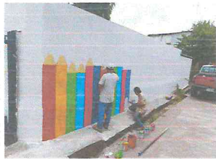
FOTOGRAFÍA No. 5 PINTURA EN MUROS
