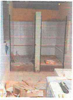
FOTOGRAFÍA No. 11 COLOCACIÓN DE AZULEJO EN ÁREA DE SANITARIOS
