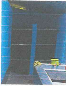
FOTOGRAFÍA No. 7 SUSTITUCIÓN DE CHAPAS EN PUERTAS
