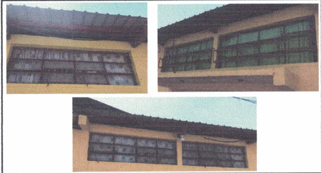
Foto 2. Sustitución de ventana de metal por ventana pvc
