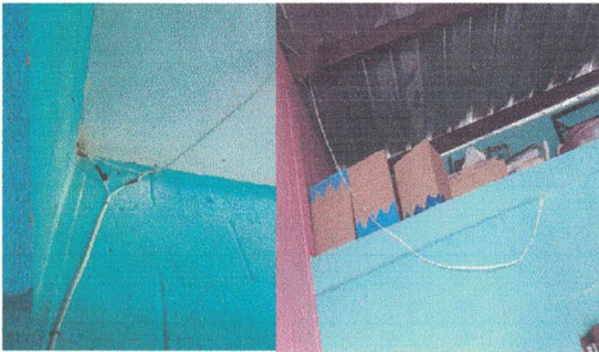
Foto 9. Reparación de cableado eléctrico
