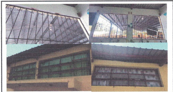
Foto 3. Sustitución de balcones de metal
