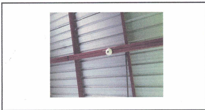
Foto 6. Sustitución de plafoneras
