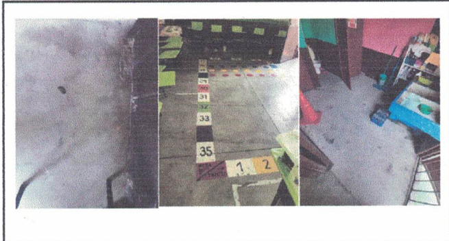
Foto 4. Sustitución de piso de torta de concreto
