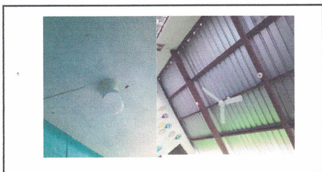
Foto 5. Sustitución de focos ahorradores
