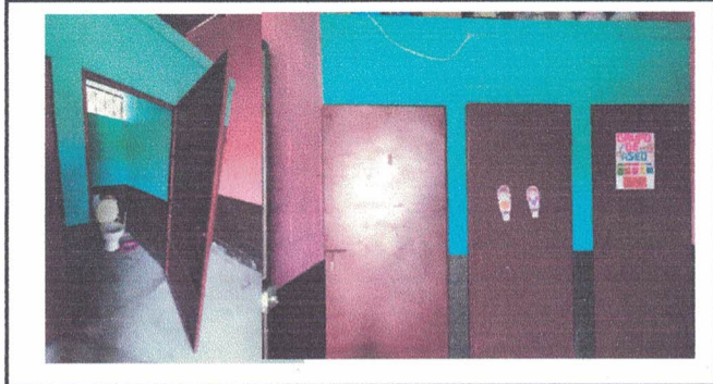
Foto 14. Reparación y sustitución de azulejo
