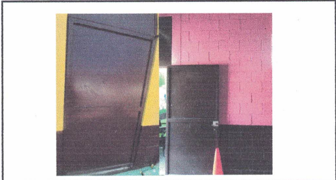
Foto 1. Mantenimiento a estructura de metal (lijado, cepillado, aplicación de pintura en puertas)
