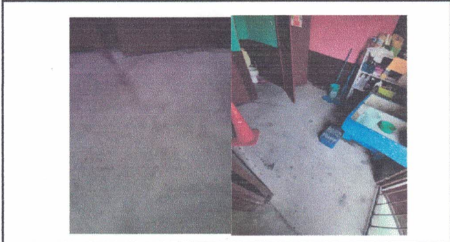
Foto 15. Sustitución de tubería línea principal de agua potable.
