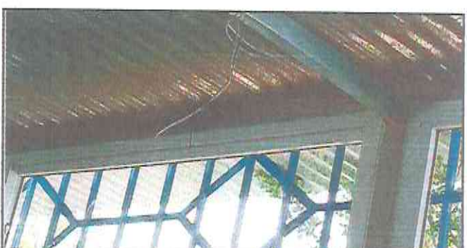
COLOCACION DE BALCONES Y VENTANAS DE PVC
