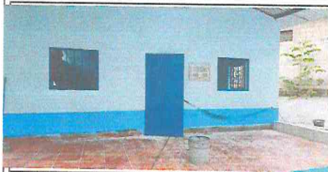
COLOCACION DE PUERTA DEL SALON DE CLASES
