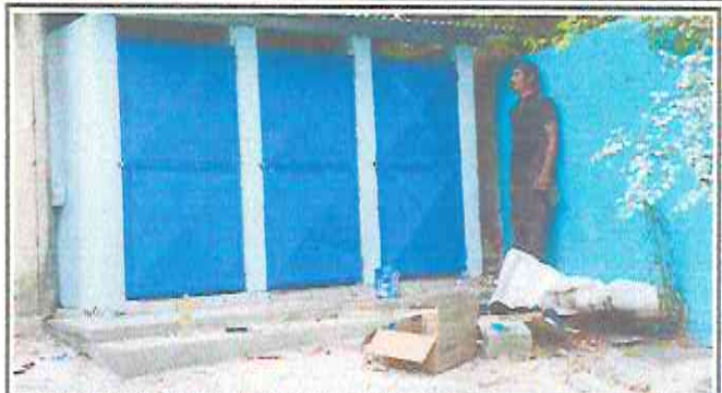
COLOCACION DE PUERTAS LIJADAS Y PINTADAS
