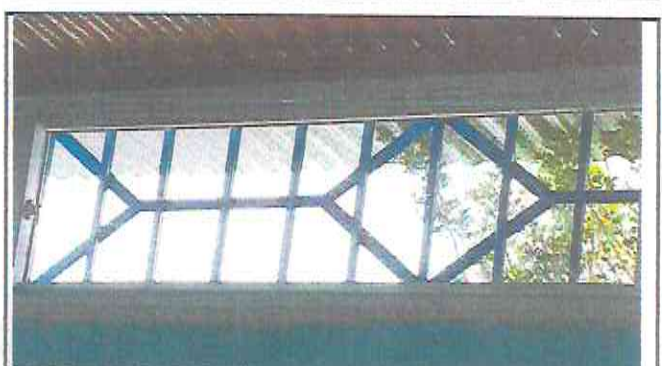
COLOCACION DE BALCONES
