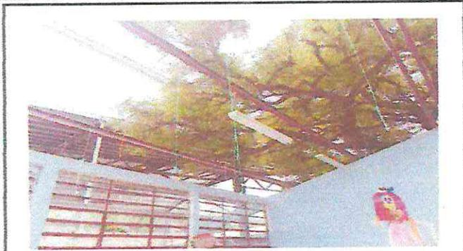
Foto 1: Sustitución de lamina, sustitución de elementos de fijación
