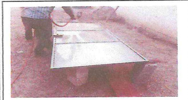
Foto 3: mantenimiento a estructura de puerta, sustitución de chapa.
