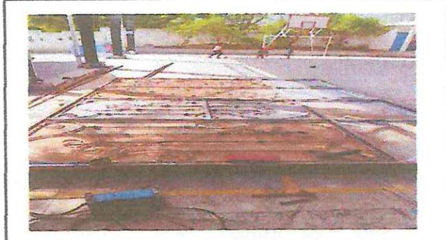
Foto 4: sustitución de portón de metal de 5.50 de largo x 3.50 de alto.
