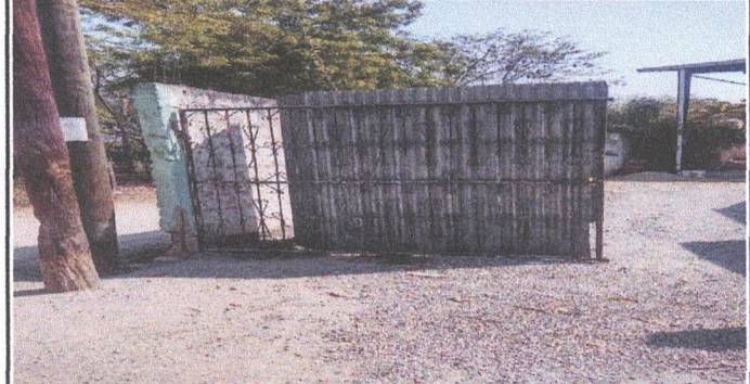
Foto 4: sustitución de portón de metal de 5.50 de largo x 3.50 de alto. 4.5
