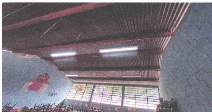
Foto 7: Instalación de unidades de fuerza tomacorriente, incluye cable eléctrico. 19.12
