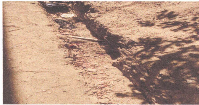
Foto 8: Instalacion de tuberia PVC 1/2" para habilitar servicio de tinaco. 18.2
