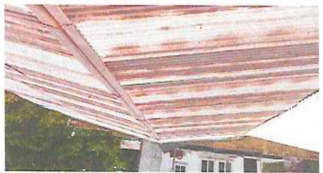
Foto Sustitución de lámina y estructura metálica en techo
