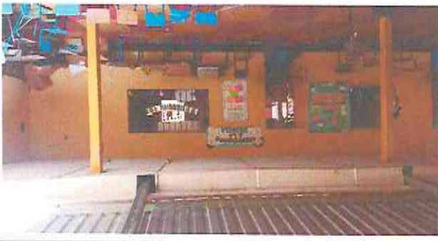
Foto 4: Mejoramiento de estructura de soporte
