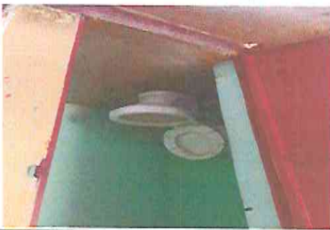
Foto 2: Mejoramiento en sanitarios
