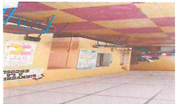
Foto 1: Mejoramiento de corredor y aulas
