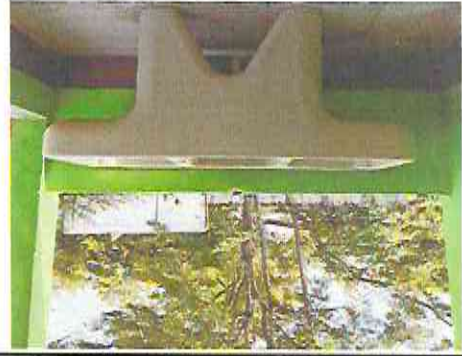
Foto 3: Finalización de pila
