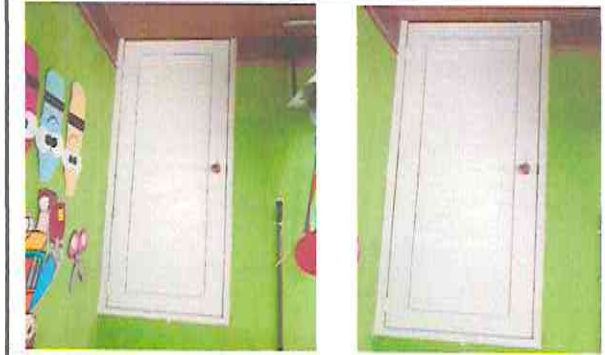
Foto1: Finalización de puertas
