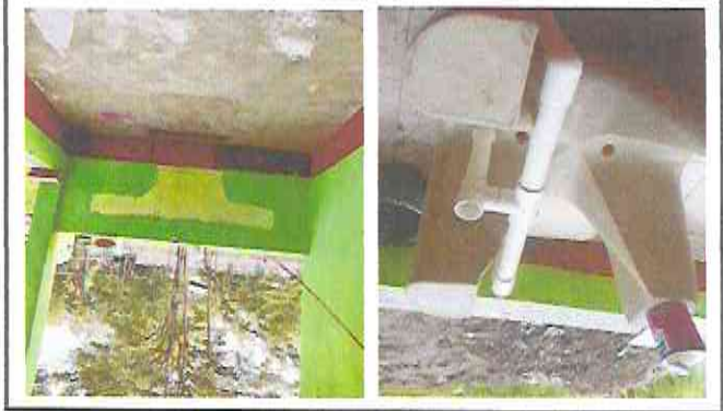
Foto 3: Retiro de pila
