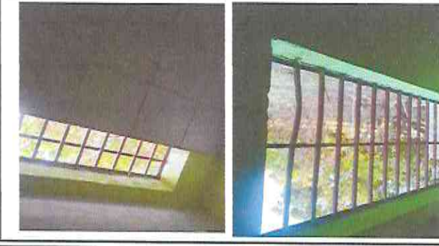
Foto 2: Sustitución de Ventanas
