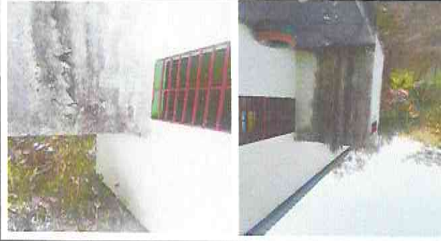
Foto 4: Instalación de depósito de agua
