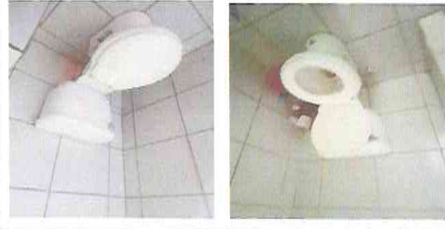
Foto 6: Sustitución de accesorios para inodoros
