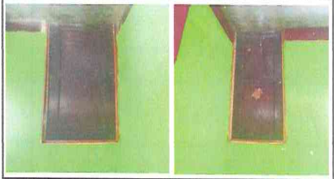
Foto 1: Sustitución de Puertas
