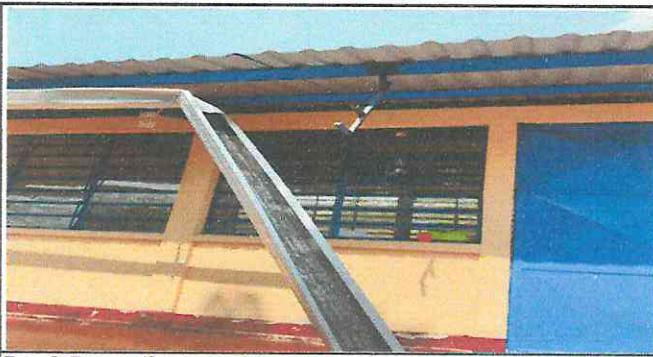
Foto 5: Reparación de canales
