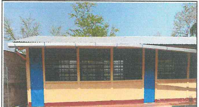
Foto 2: Pintura de paredes y puertas de metal.
