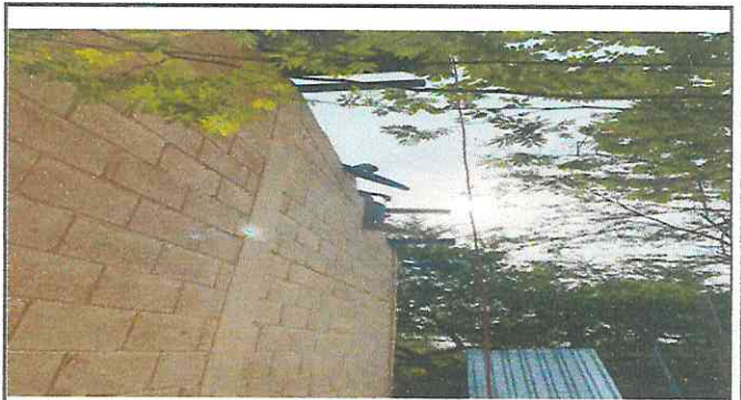
Foto 4: Reparación de lámina y costanera
