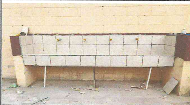
Foto 1: Reparación de chorros en lavamanos y pegado de azulejo
