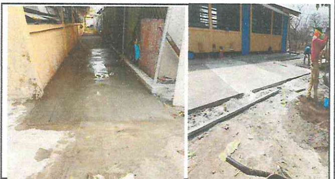
Foto 6: Construcción de planchas de concreto en áreas de recreación y entrada principal a párvulos.
