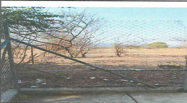
Foto 3: Sustitución de malla, y tubo galvanizado en muro perimetral
