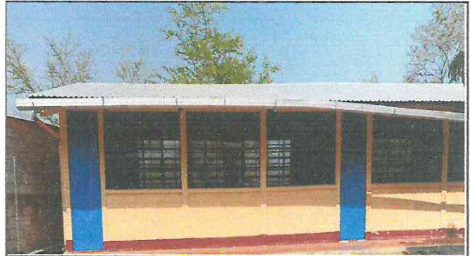
Foto 2: pintura de paredes y puertas
