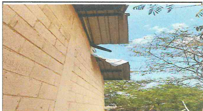
Foto 4: Reparación de lámina y costaneta
