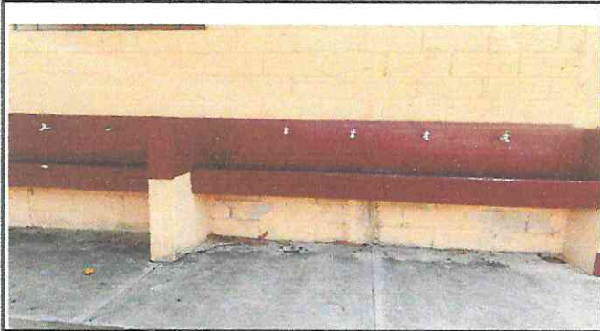
Foto 1: Reparación de chorros para lavamanos y pegado de azulejo
