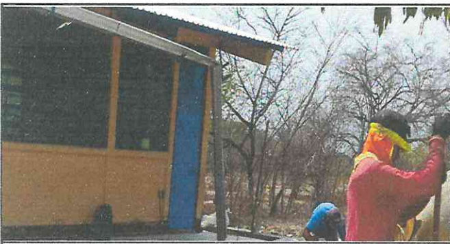
Foto 5: Reparación de canales
