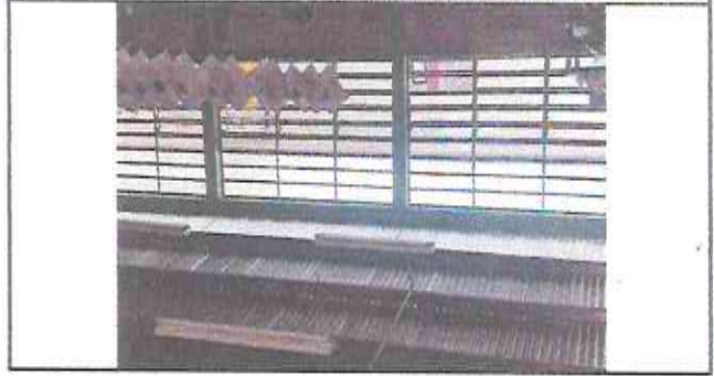
Foto 5: Colocación de malla en ventanas.
