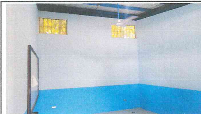
Foto 2: Aula de Primaria. Debidamente Rehabilitada.
