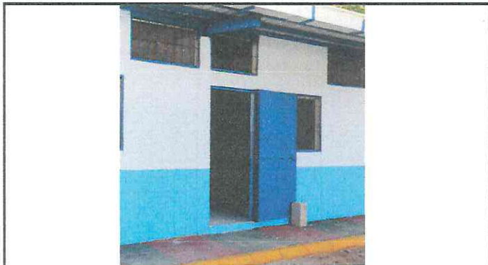
Foto 1: Aula de Primaria. Debidamente Rehabilitada.
