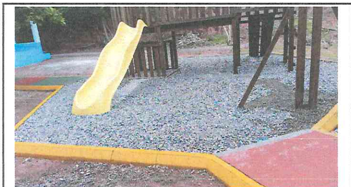
Foto 3: Reparación y Rehabilitación de Area de Juegos con bordillos fundidos y caminamientos. Debidamente Finalizados.
