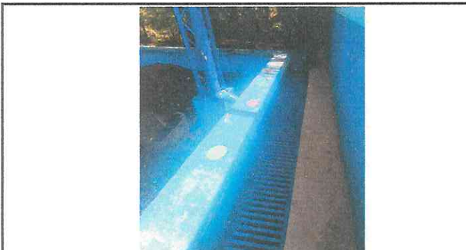
Foto 6: Cunetas Metalicas Finalizada.
