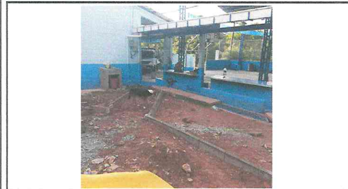
Foto 7: Reparación y Rehabilitación de Area de Juegos con bordillos y caminamientos.
