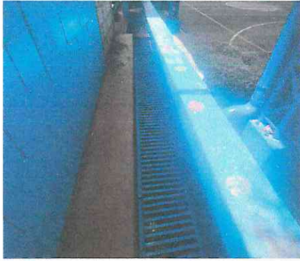
Foto 13: Rehabilitación de Cuneta con Rejillas.
