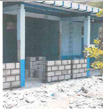
Foto 4: Reparación de Aula de Primaria.
