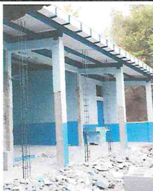
Foto 3: Reparación de Aula de Primaria.
