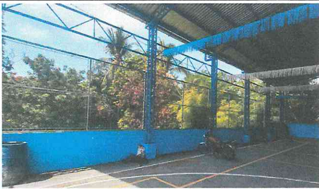
Foto 15: Cerramiento a Muro Perimetral del Muro de Contención.
