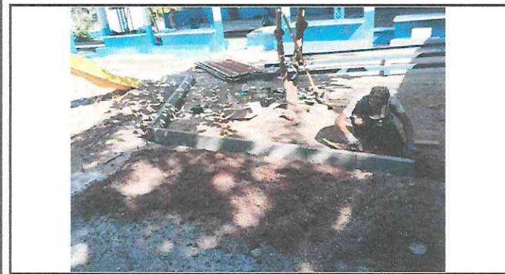
Foto 9: Reparación y Rehabilitación de Area de Juegos con bordillos y caminamientos.
