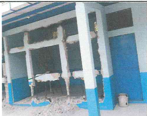
Foto 1: Reparación de Aula de Primaria.
