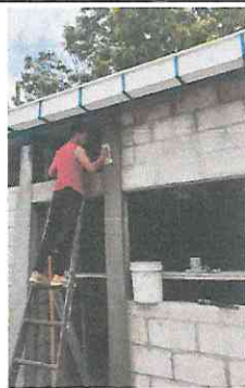
Foto 5: Reparación de Aula de Primaria.
