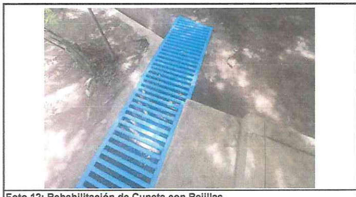
Foto 12: Rehabilitación de Cuneta con Rejillas.
