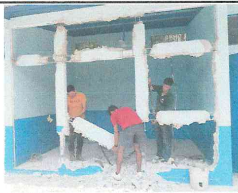
Foto 2: Reparación de Aula de Primaria.
