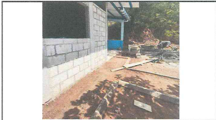
Foto 8: Reparación y Rehabilitación de Area de Juegos con bordillos y caminamientos.
