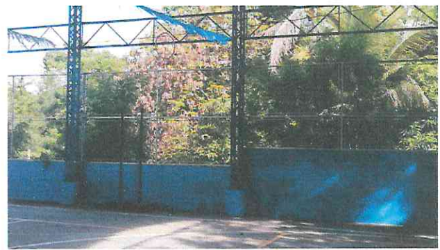
Foto 16: Cerramiento a Muro Perimetral del Muro de Contención.
