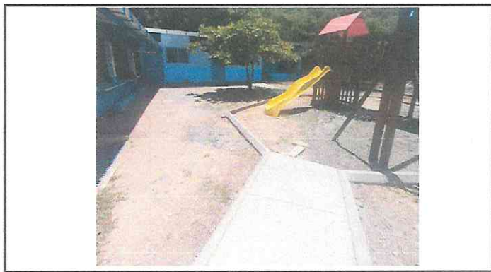
Foto 10: Reparación y Rehabilitación de Area de Juegos con bordillos y caminamientos.
