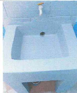
Foto 6: Reparación de Lavamanos de Primaria.
