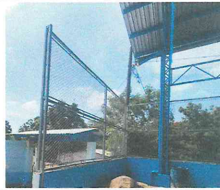
Foto 14: Cerramiento a Muro Perimetral del Muro de Contención.
