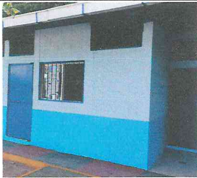
Foto 17: Aula de Primaria y Caminamientos Finalizados.
