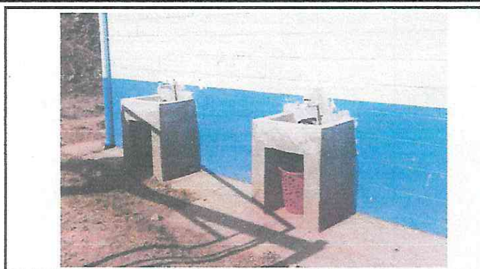
Foto 2: Reparación de Lavamanos de Primaria
