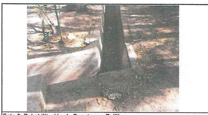
Foto 5: Rehabilitación de Cuneta con Rejillas
