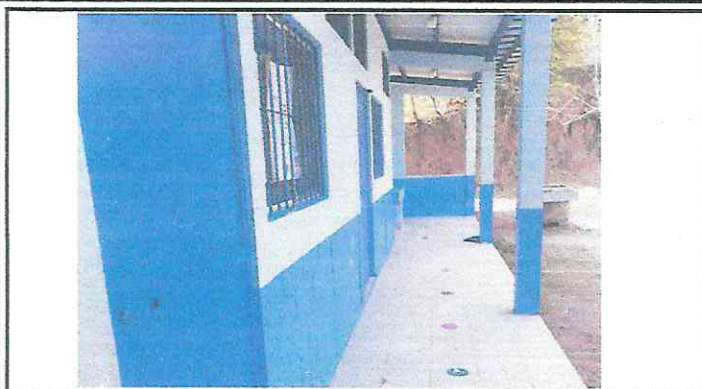
Foto 1: Reparación de Aula de Primaria y Protección a puerta metálica.
