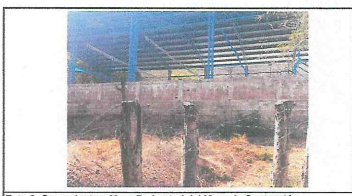
Foto 6: Cerramiento a Muro Perimetral del Muro de Contención.
