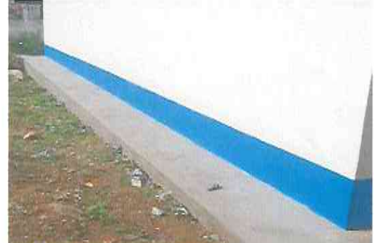
Foto 10: Acera construida, para la protección de muro de la escuela, evitando humedad y caída de repello.
