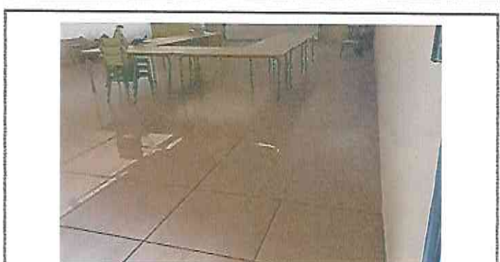
Foto 4: Colocación de piso cerámico, en módulo de aula.
