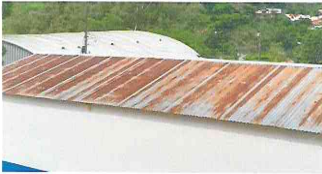
Foto 9: Capote nuevo instalado en lámina, evitando daños por lluvia en módulo de aula.
