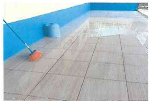
Foto 8: Instalación de piso cerámico en módulo de corredor.
