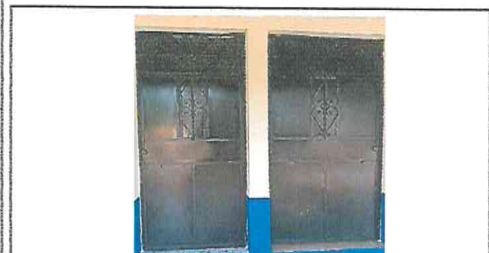
Foto 3: Puertas nuevas colocadas en módulo de aula y baño.
