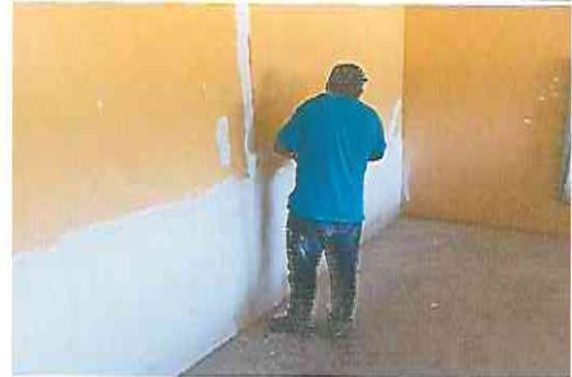
Foto 6: Reparación de grietas, con cernido y repello en módulo de aula.
