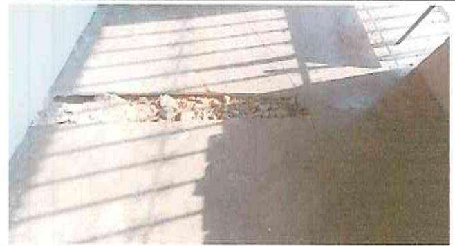
Foto 8: Proceso de demolición y nivelación de torta de cemento para colocación de piso en área de corredor.
