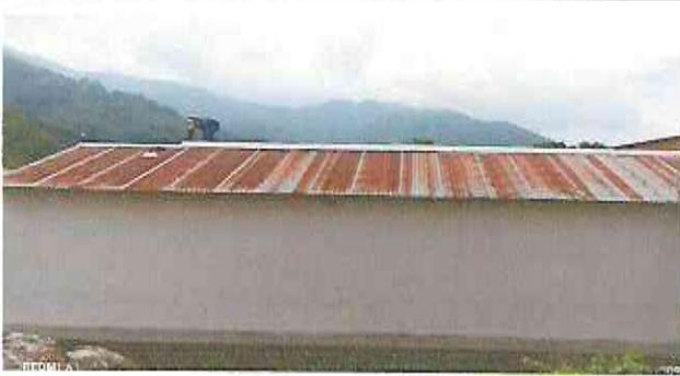
Foto 9: Sustitución de capote de lámina, para evitar daños por lluvia.
