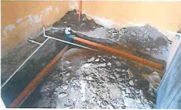
Foto 1: Proceso de instalación de drenaje de aguas negras, excavación, demolición e instalación de tubería.
