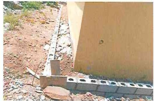
Foto 10: Relleno y nivelación de cemento para la construcción de acera para protección de muro de la escuela.
