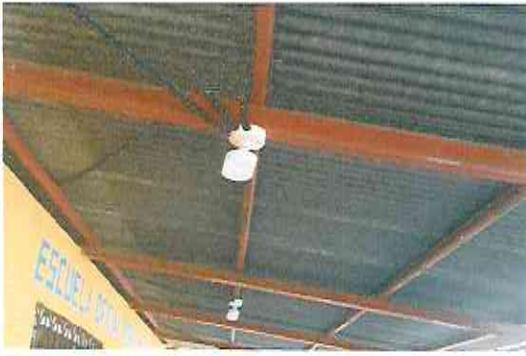
Foto 7: Proceso de instalación de nuevo cableado eléctrico e iluminación en módulo de corredor.
