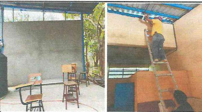
Foto 3: Instalación de pared para fondo de escenario y reparación de lámparas en los baños.
